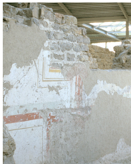
Aufgehendes Mauerwerk unter dem Schutzgebäude von 1987
